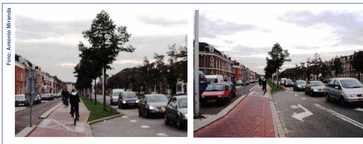
FIGURA 106 - Exemplos de terrapleno separador de ciclovia de via com grande movimentação de veículos motorizados, Utrecht – Holanda, 2006.
