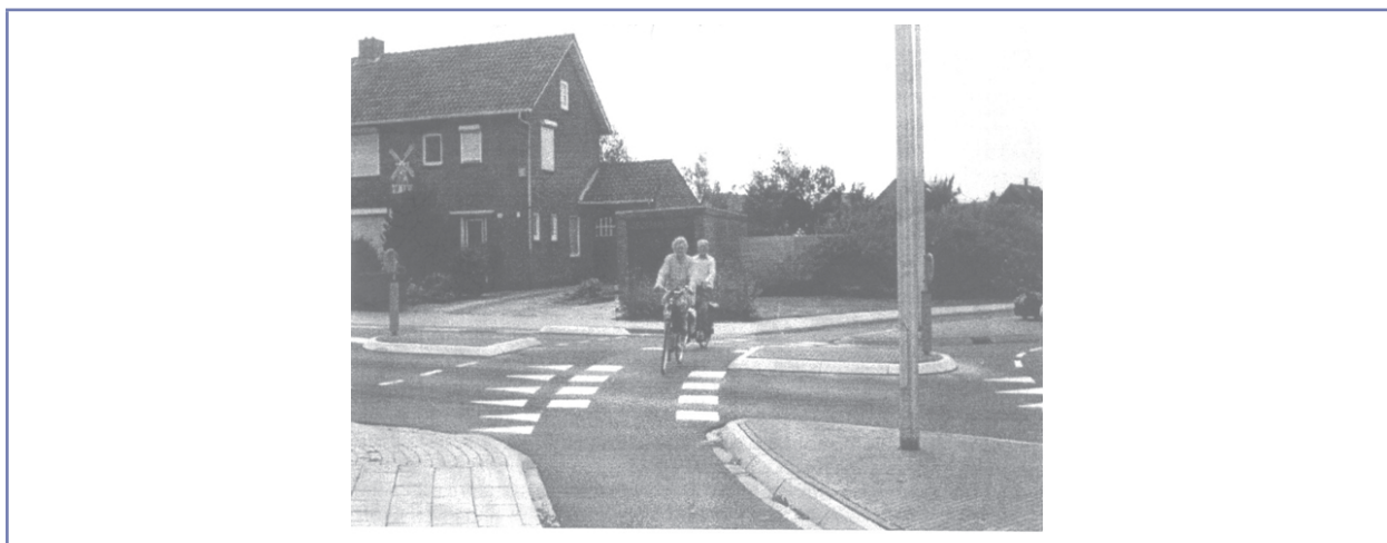
FIGURA 131 12 - Travessia de ciclista por tramo exclusivo para bicicletas, em espaço adjacente de rotatória localizada em bairro residencial. Holanda, 2004.
