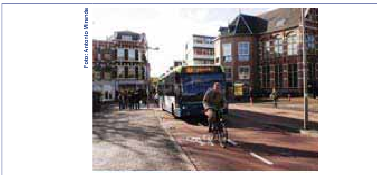
FIGURA 90 - Ciclofaixa implantada em trecho de via com reduzida largura de pista, Leiden, Holanda, 2006.
