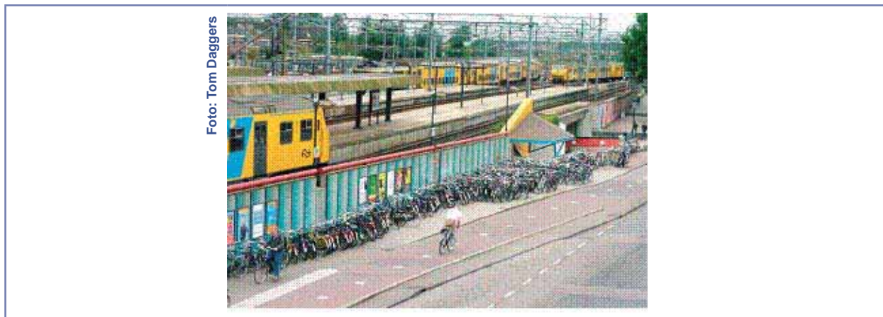
FIGURA 220 - Vista da parede lateral da Estação Central de Trens de Utrecht – Holanda, 2006.
