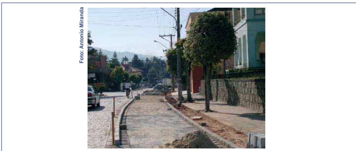
FIGURA 64 - Ciclovía separadora do tráfego motorizado por meio-fio, em obras – Pomerode/SC, 2006 29 .
