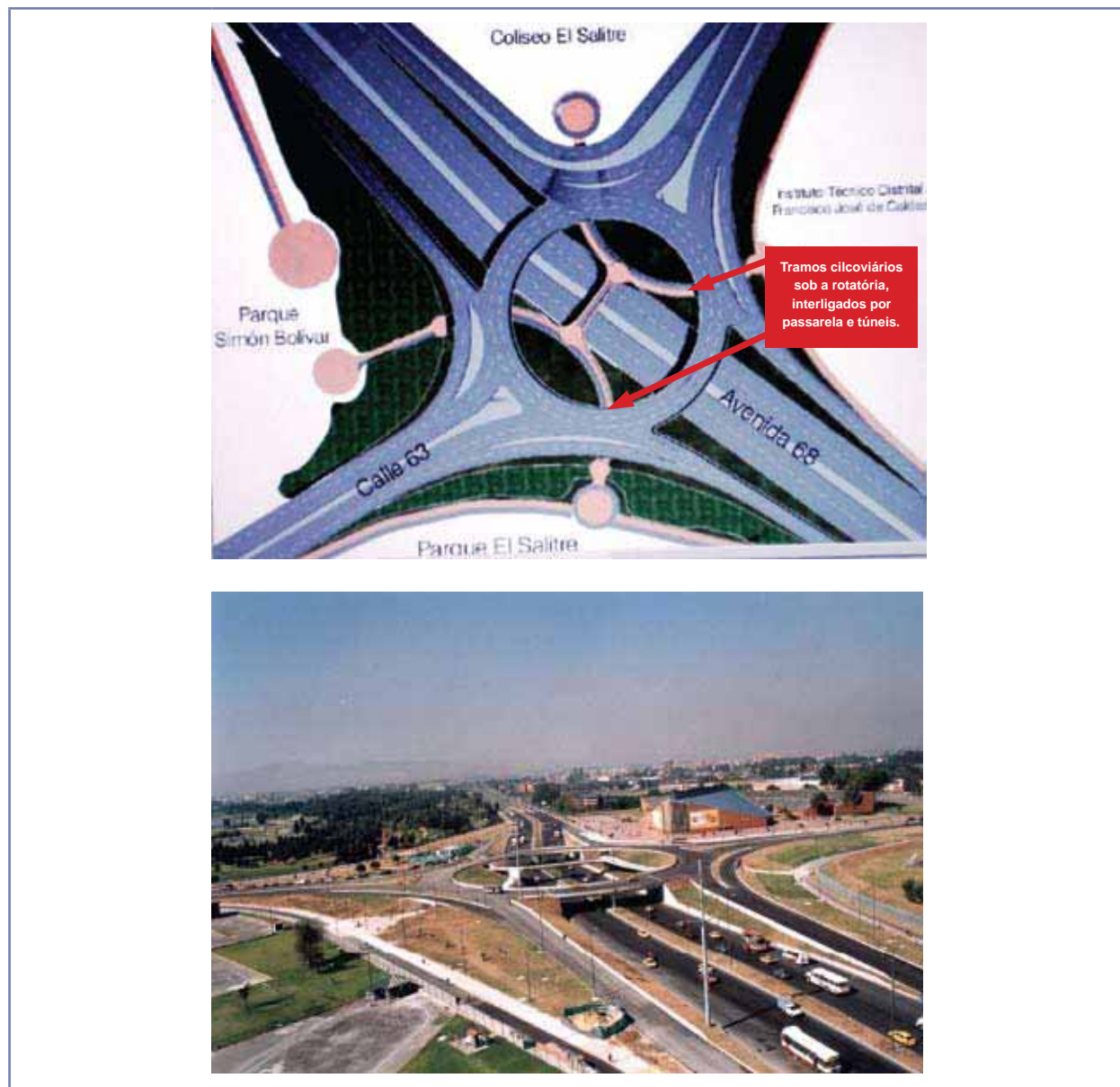
FIGURAS 145 e 146 - Interseção da Avenida 68 com a Rua 63 com três níveis, sendo o último deles uma rotatória e o segundo passarelas cicloviárias. Bogotá – Colômbia, 2003.
