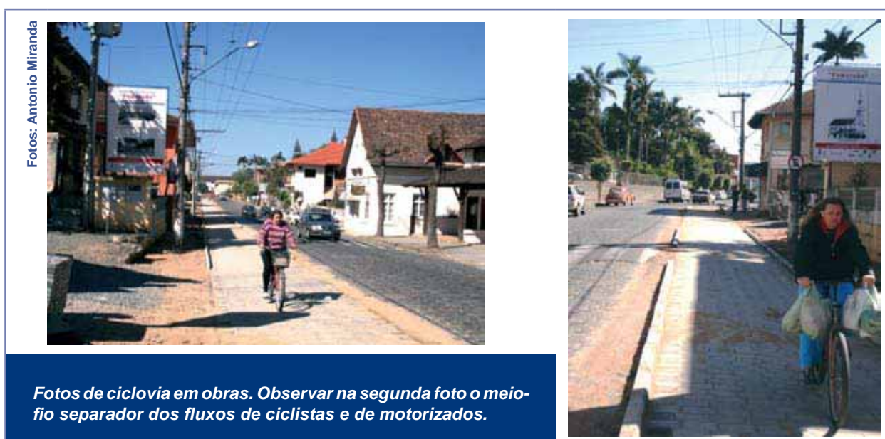
FIGURA 79 - Flagrantes de ciclovia em construção, Pomerode-SC, 2006 29 .
