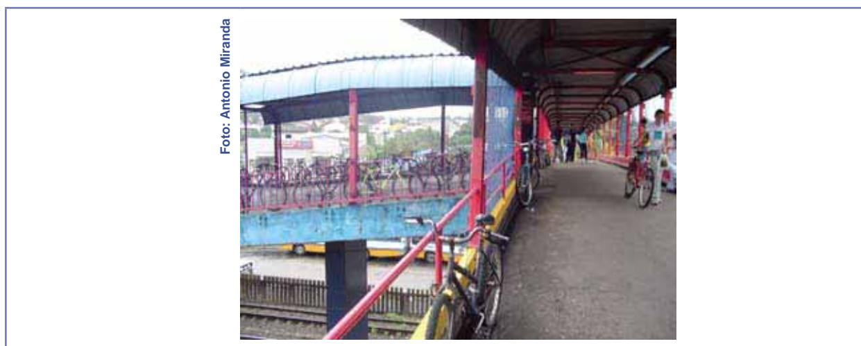
FIGURA 226 - Bicicletas estacionadas junto aos corrimãos das rampas de acesso à linha de bloqueio na Estação Niterói, na Grande Porto Alegre-RS – Brasil, 2005.
