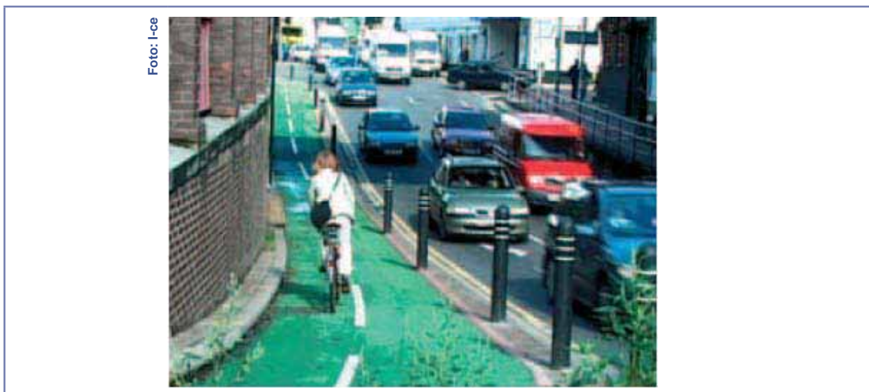
FIGURA 65 - Ciclovía separada do tráfego motorizado por espaço, pinturas e ciclolitos – Londres, 2006.
