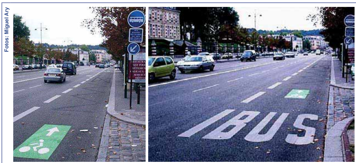
FIGURA 214 - Faixa exclusiva para ônibus com largura ampliada na cidade de Paris – França, 2003.
