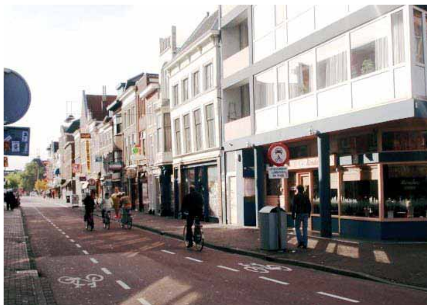
FIGURA 92 - Ciclofaixa implantada em trecho de via com reduzida largura de pista, Leiden, Holanda, 2006.
