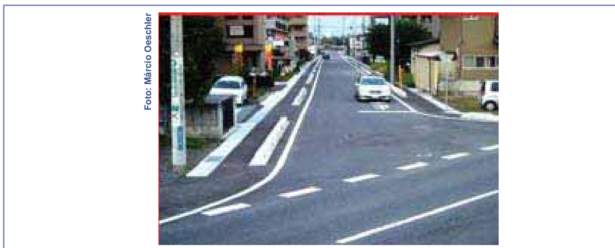
FIGURA 85 - Via ciclável segregada por blocos de concreto nos arredores de Kobe, Japão, 2005.
