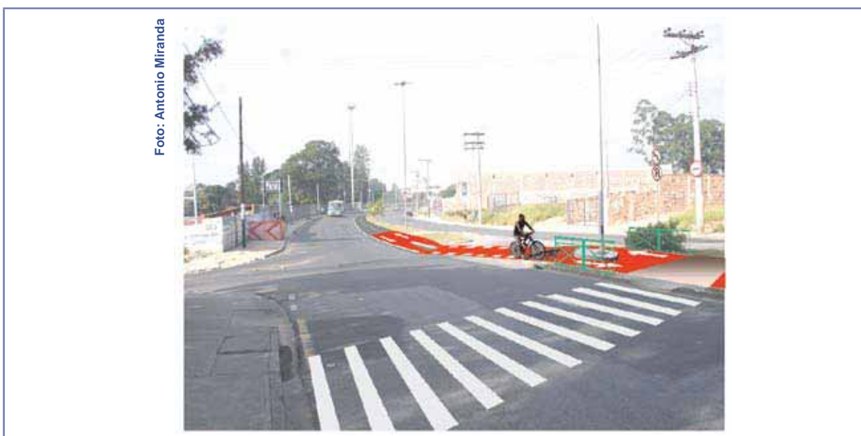
FIGURA 114 - Ciclovia no canteiro central com ilha separadora Projeto da Ciclovia da Avenida Itavuvu, Sorocaba, Brasil, 2006.
