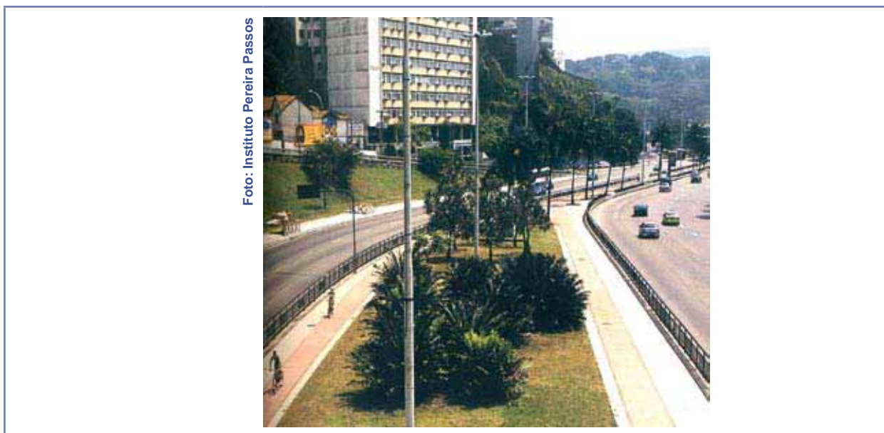
FIGURA 60 - Ciclovía unidirecional no canteiro central na zona sul da cidade do Rio de Janeiro/RJ, 2000.
