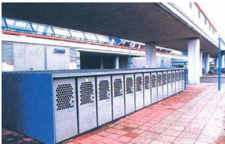
FIGURA 209 - Conjunto de biciclex sob linha de metrô no subúrbio de Paris – França, 2001.
