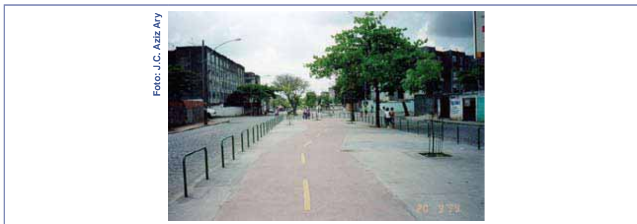
FIGURA 155 - Pavimento colorizado com oxalato de ferro em ciclovia, Bangu/RJ.
