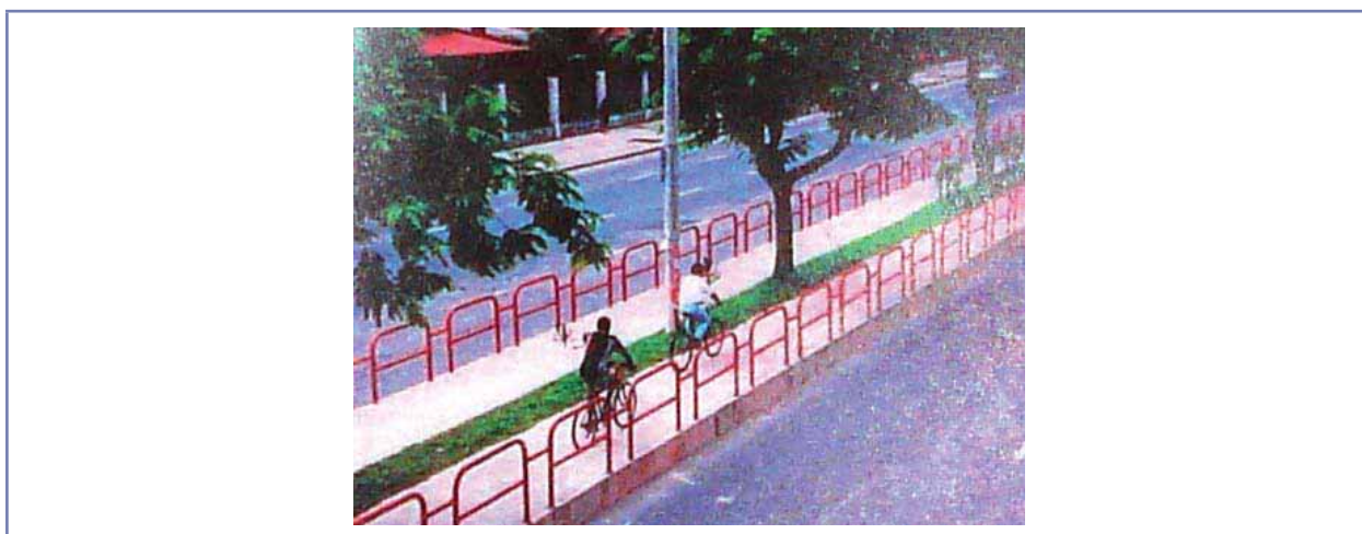
FIGURA 110 - Ciclovía no canteiro central da Avenida Almirante Barroso, Belém-PA, Brasil, 2002.
